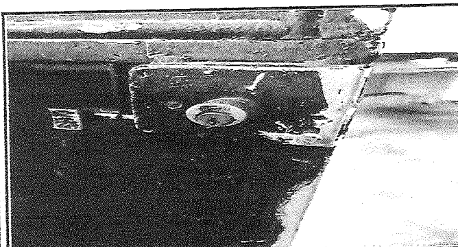
Foto 5: Las chapas de los diferentes salones estan deterioradas y otras no agarran llave.
